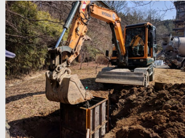
▲ Installation of Seismometer Platform (Feb 2019) Installation der Seismometerplattform (Feb. 2019)
